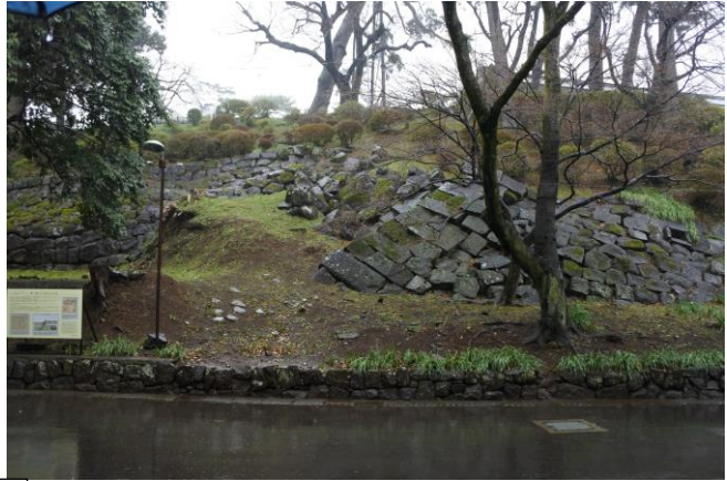
関東大震災の際に崩れ落ちた石垣がそのまま残されていました。
