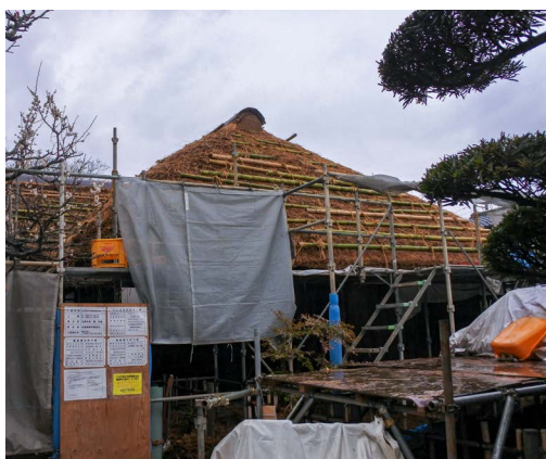
旧河原家の茅葺き工事
